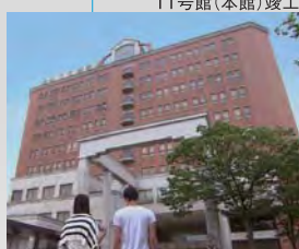
11号館(本館)竣工
