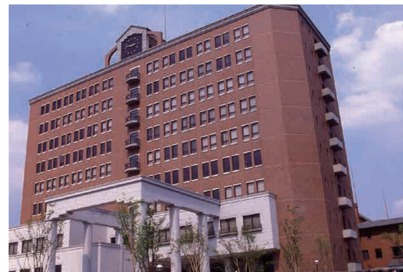
大阪産業大学本館(11号館)竣工(昭和61年8月)
