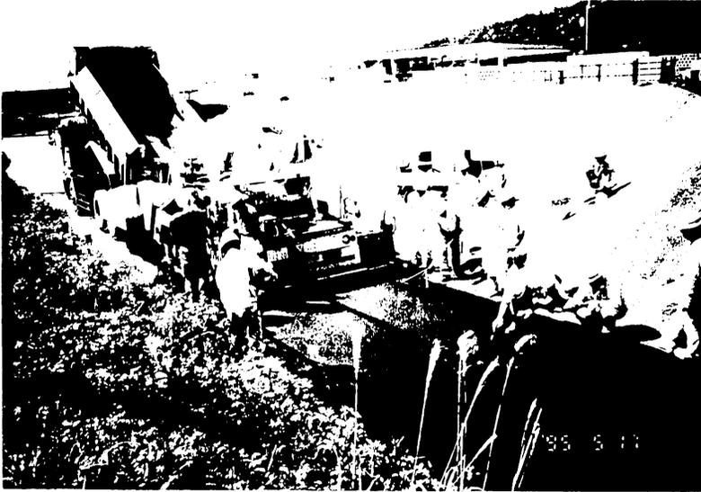
図-14 Reアスコンの試験施工
